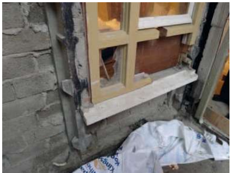
AFB.15. Destructief onderzoek van kozijnen in de achtergevel van de proefwoning, 2010 (foto Hielkje Zijlstra)
